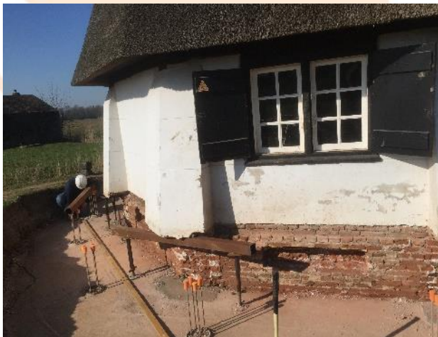
▲ bovenkanten palen staan gereed om ijzerconstructie fundering te ontvangen, begin maart
