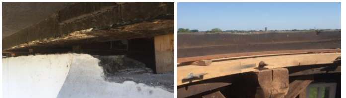
▲ 8-kant aan 1 zijde 12cm opgekrikt, 31-05-2021 en daarna ook bovenop alles weer waterpas gemaakt.
