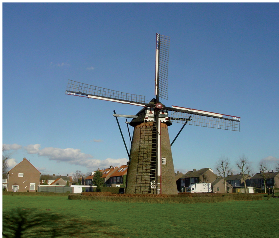
Afb. 4. De nieuwbouw nadert de molen in Hapert.
