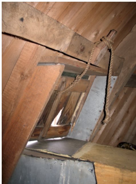
Afb. 12. Rottend luik boven de lange spruit.
