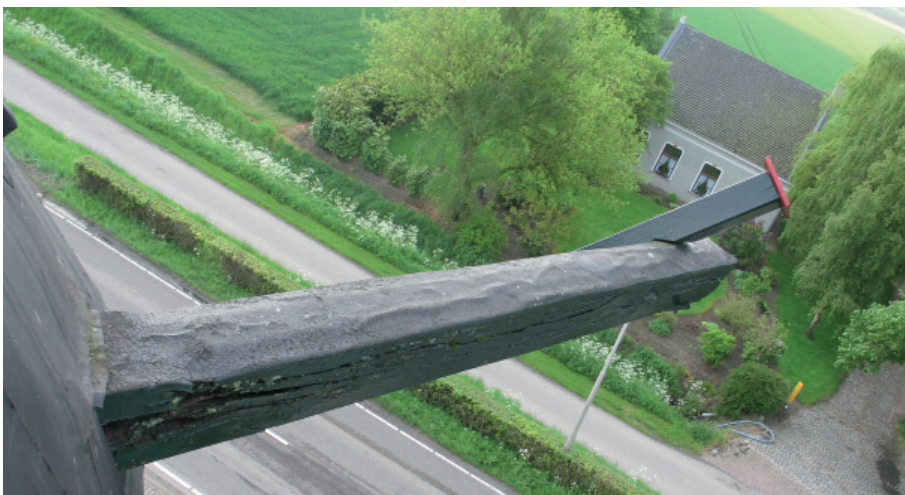
Afb. 10. Sterk inwaterende en rottende lange spruit.
