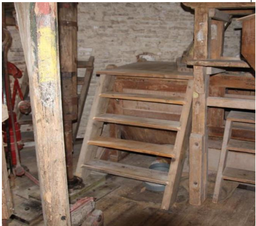
Herstelwerk trappen en vervangen kort trapje maalzolder.
