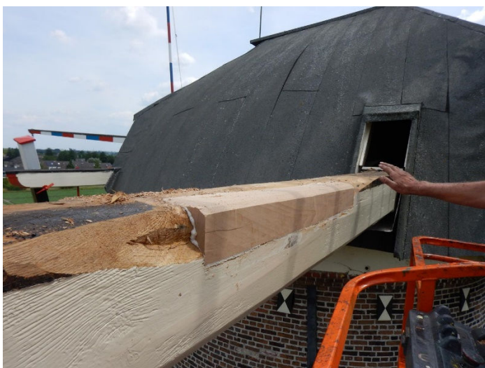
Herstellen ingerot houtwerk lange spruitbalk voor aanbrengen EPDM.
