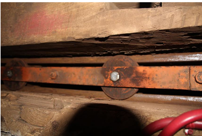
Hersteld rollenwerk molenkap.
