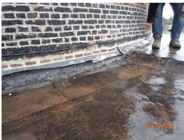
Vervangen randlood molenromp boven molendek.
