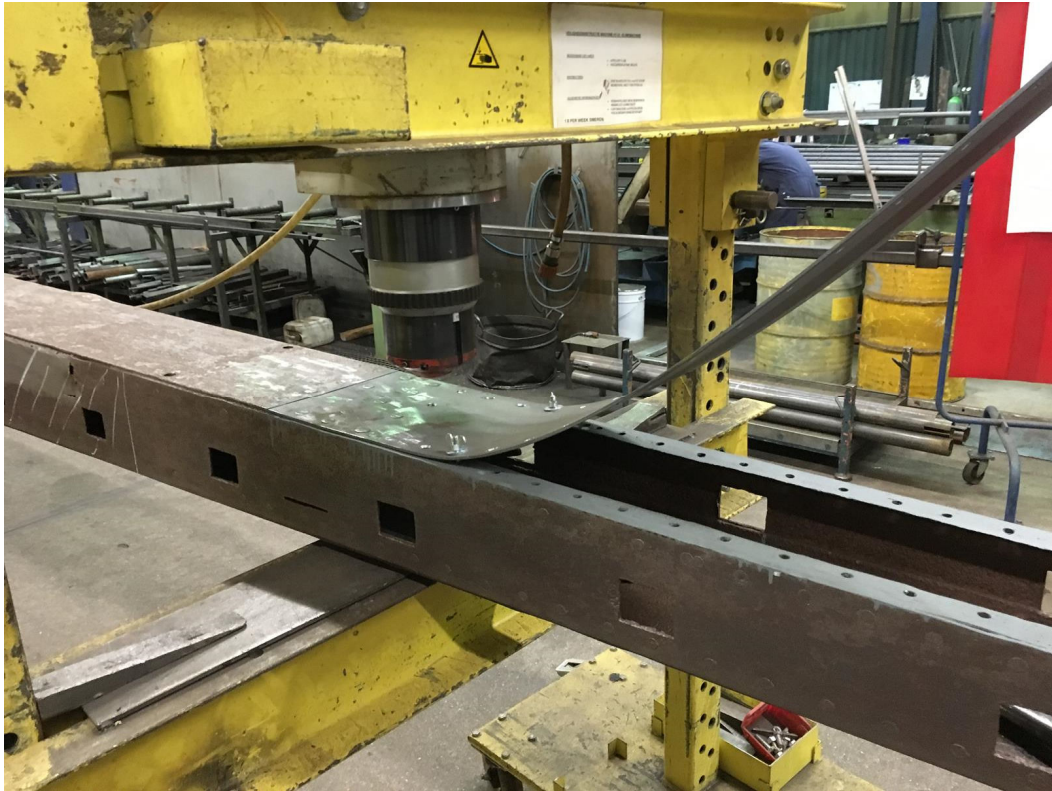
Plaatsen nieuw plaatwerk.
