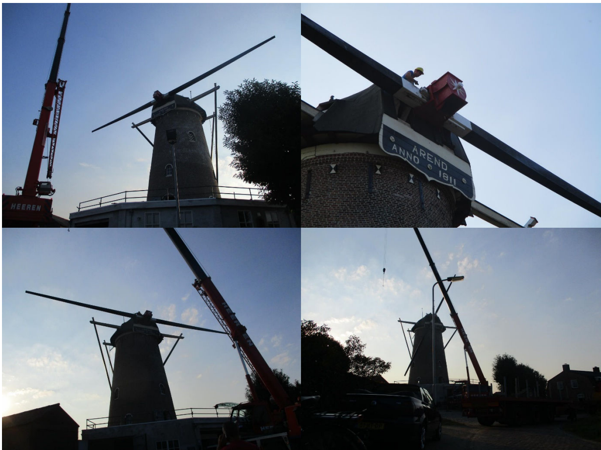
Verwijderen roeden t.b.v. restauratie.
