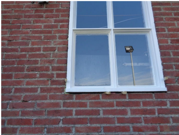
Vervangen betonnen vensters.
