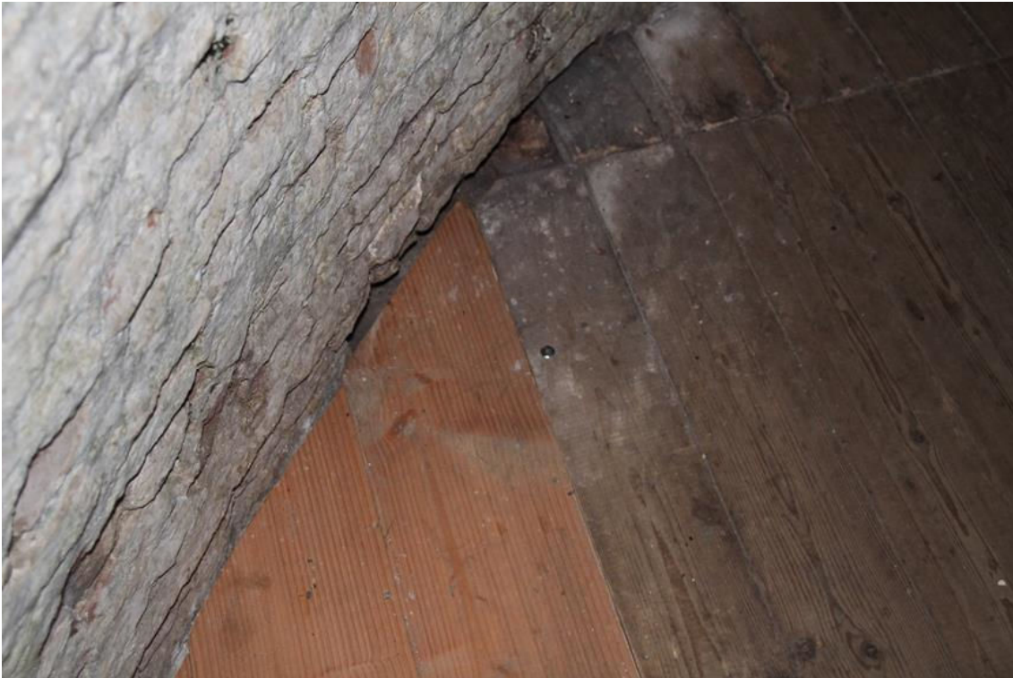
Herstellingen vloerdelen Luizolder.
