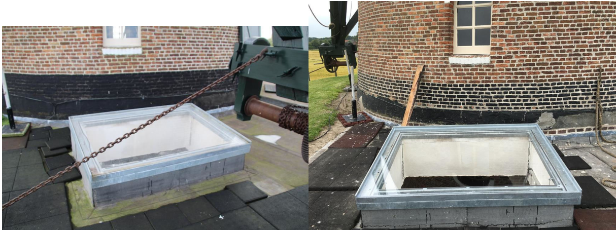
Roestvaste stalen kozijn geplaatst op de opening van het voormalig houten luik. Hierdoor is in de invaart het gevlucht zichtbaar voor bezoekers.
