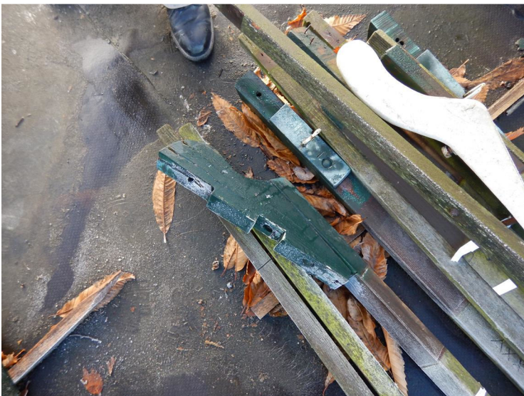
Ingerot houtwerk Kluften, Klossen en roeden.
