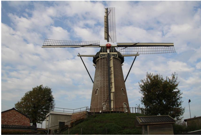
Wiekenkruis na restauratie.
