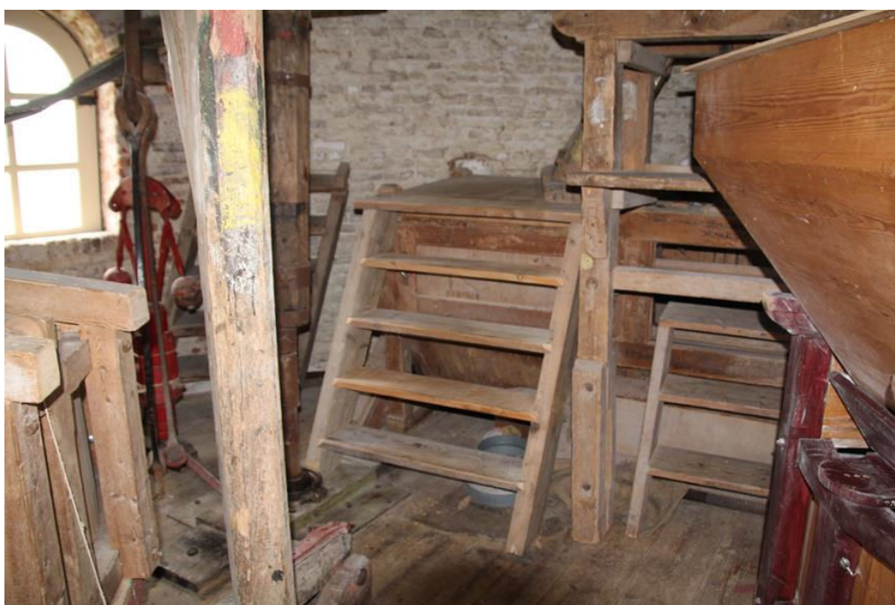
Herstelwerken trappen en vervangen kort trapje maalzolder.
