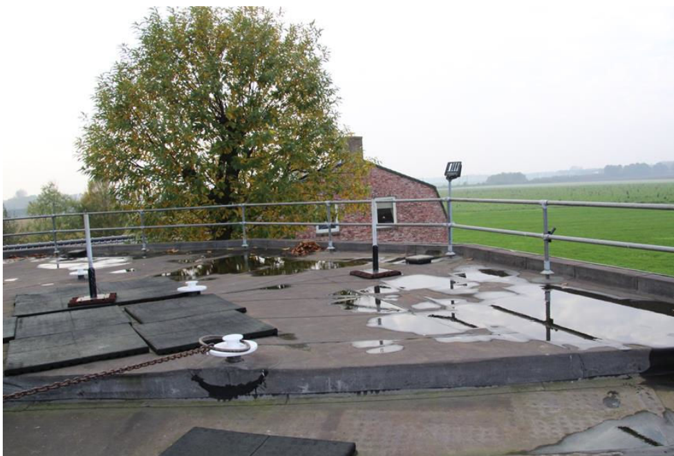
Vervangen dakbedekking WedeFlex twee laags volledig verkleefd met 40mm PIR.
