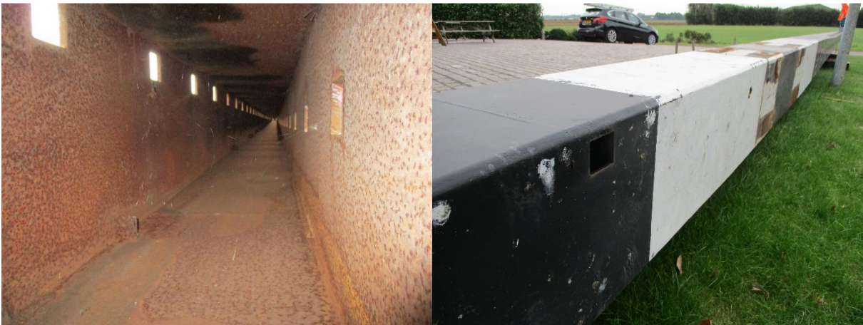
Delaste Derkx roede binnenzijde lassen gecontroleerd en buitenzijde.
