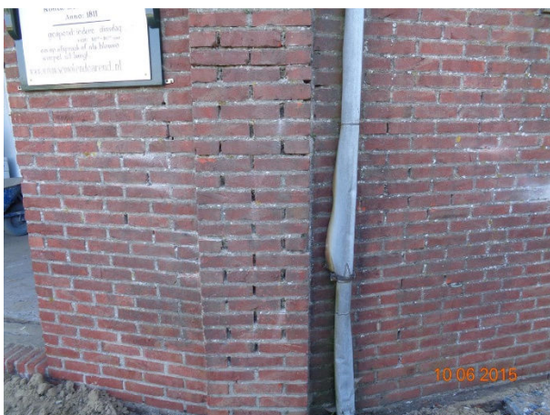
Herstellen voeg- en metselwerk buitengevels.
