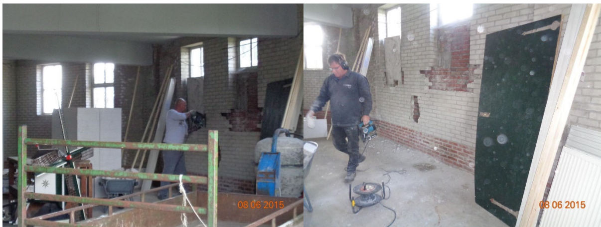
Herstel metselwerken kalkzandsteen binnenwerk.
