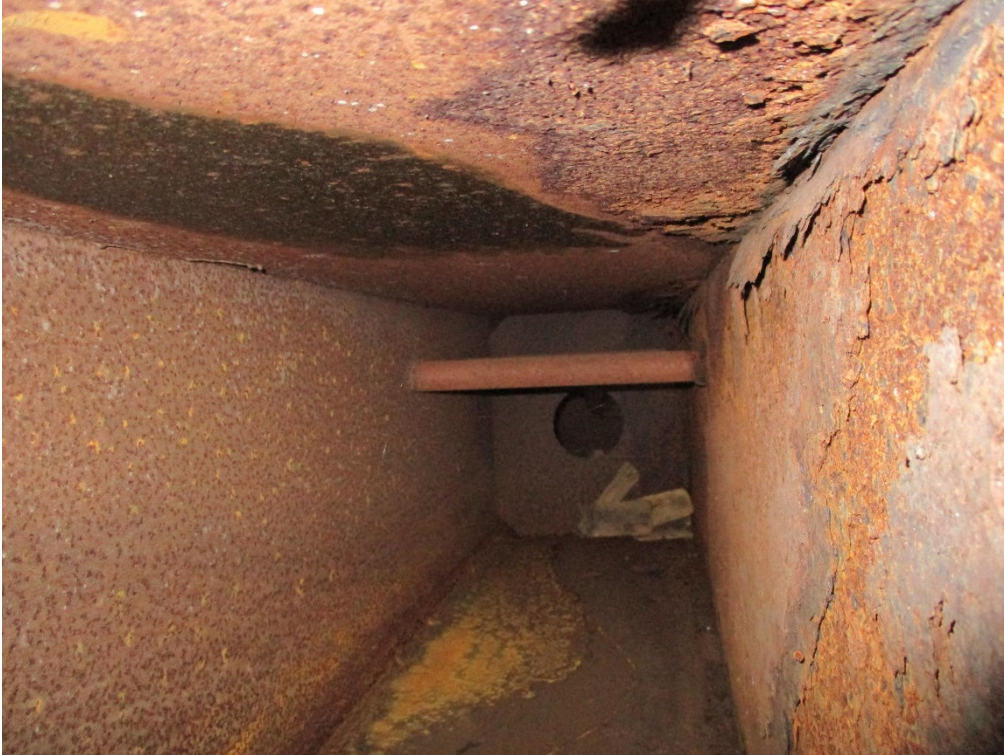
Fors geroeste plekken nabij de askop in de gelaste roede als extra werk hersteld.
