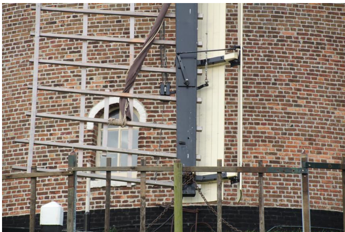
Vervangen hekwerk en Fokken.
