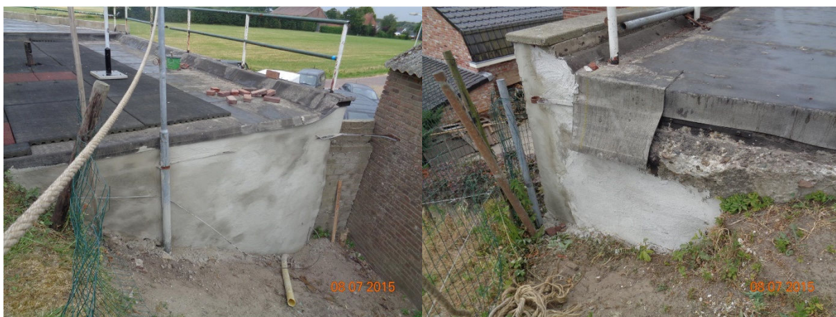
Herstelwerken metselwerk grondkeerwanden en pleisterwerk.
