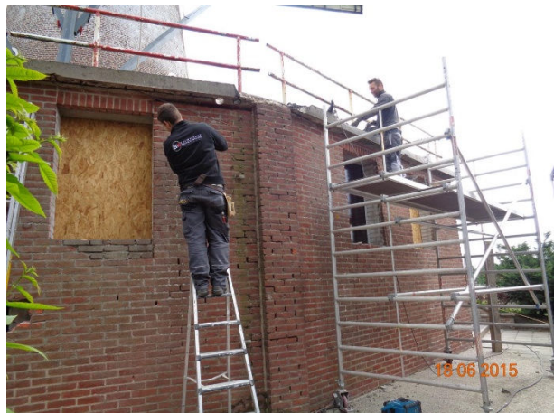
Herstellen voeg wen metselwerk buitengevels en herstel betonwerken betondek en dakranden.
