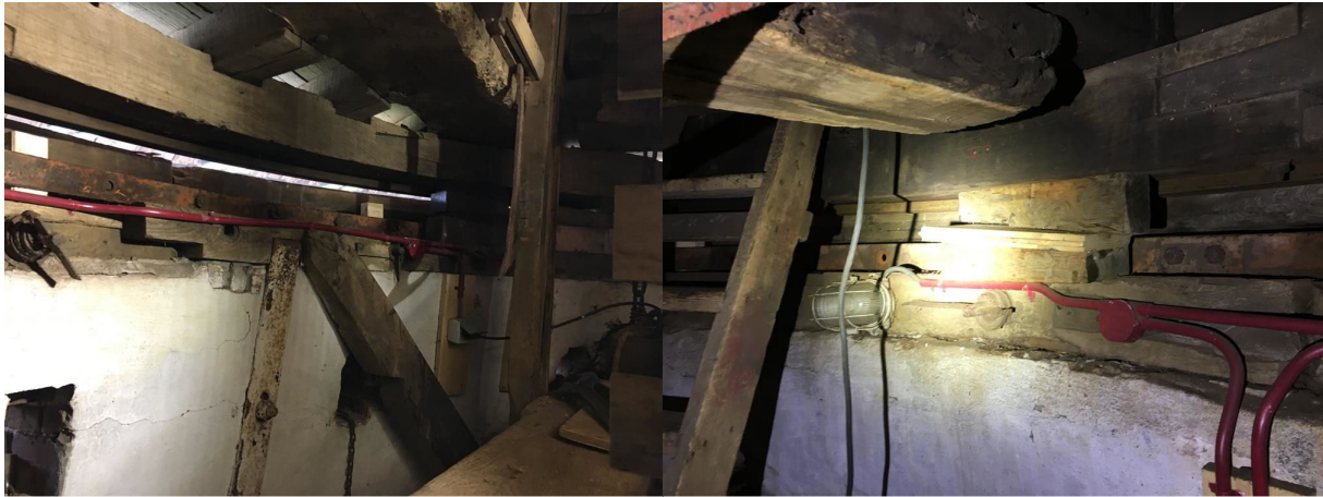
Opstempelen bovenring en uitnemen rollen en pennen/bouten.
