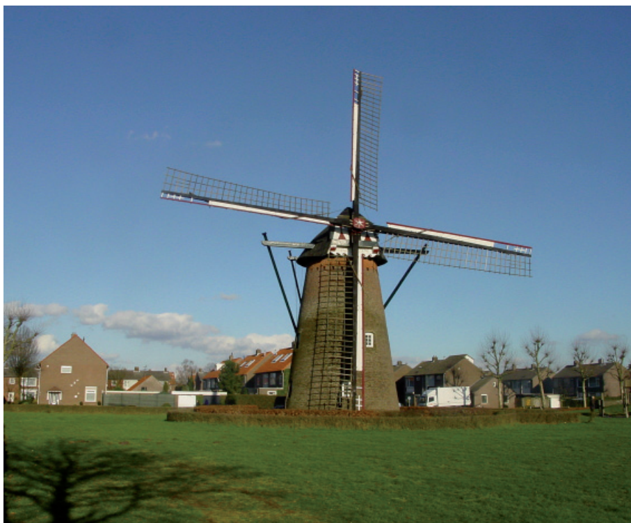
Afb. 4. De nieuwbouw nadert de molen in Hapert.
